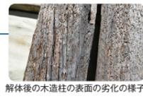
解体後の木造柱の表面の劣化の様子
